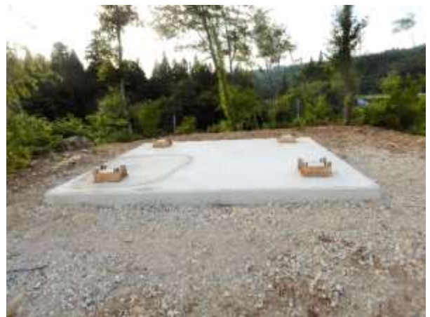
頂上には四阿の基礎部分完成
