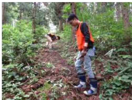
壺ノ坂の階段の整備
